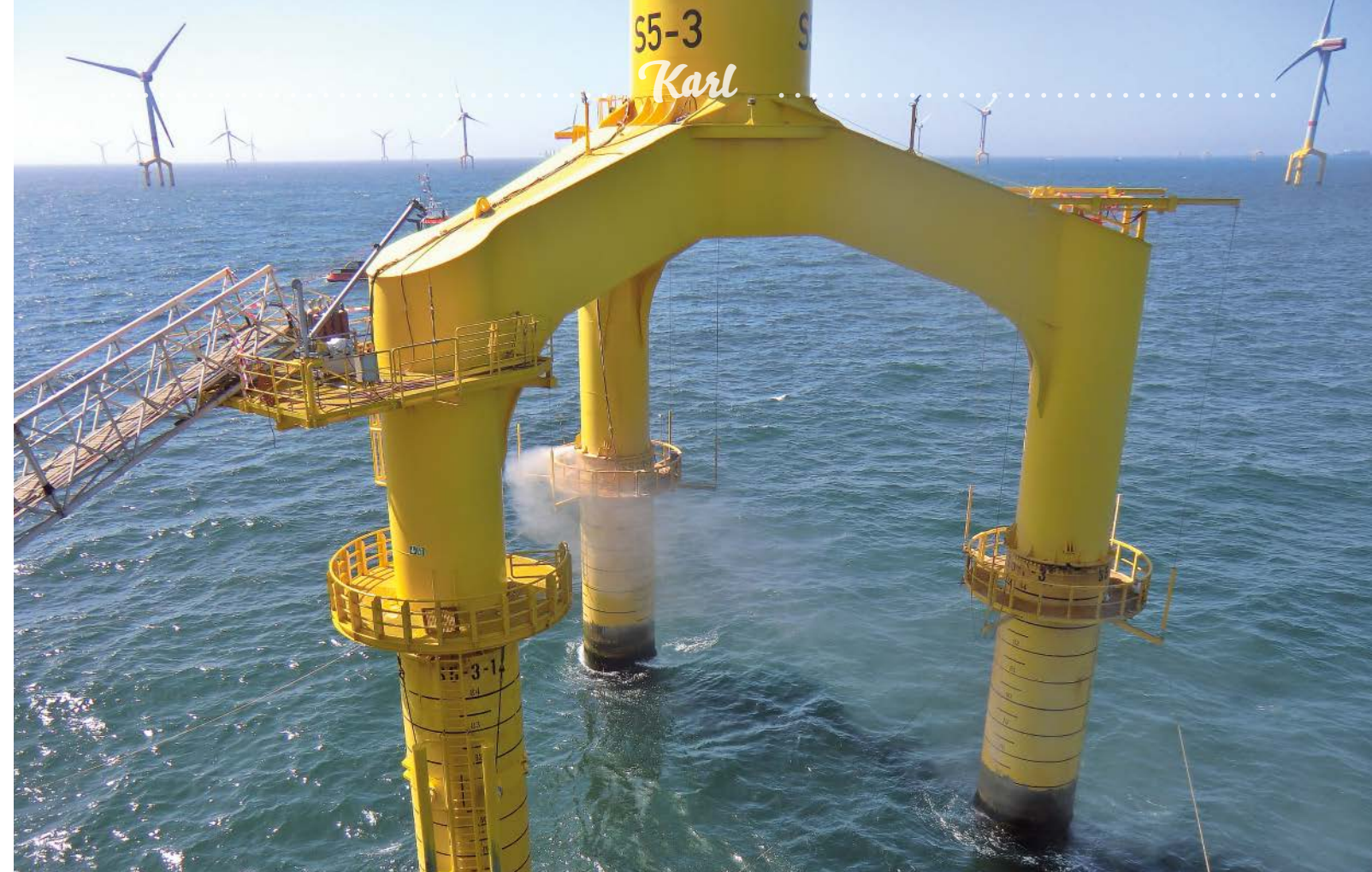
Die Tripoden der Windkraftanlagen im Offshore-Windpark BARD I stehen draußen im Meer vor der ostfriesischen Nordseeküste – ein aufregendes Arbeitsumfeld!
