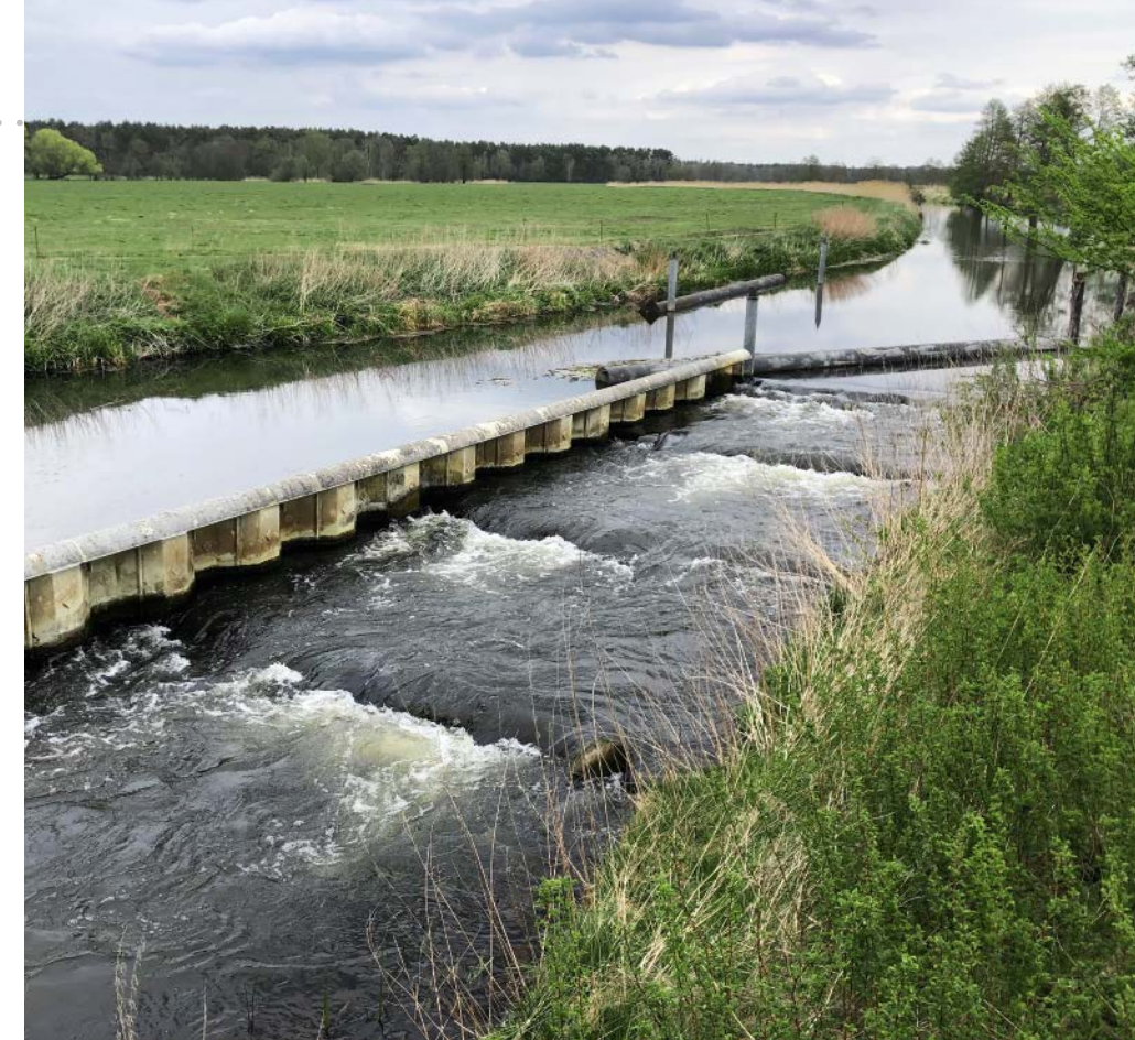
Die Treppe ermöglicht es den Fischen, das Stepenitz-Wehr zu passieren.
