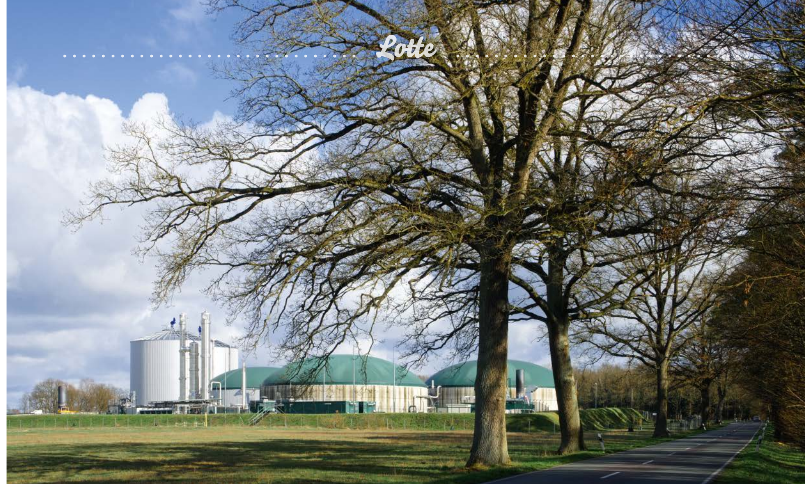
Die Biogasanlage in Wolfshagen ist eine reine »NawaRo-Anlage«, das heißt, neben Mais kommen auch Zuckerrüben, Ganzpflanzensilage und Gras zum Einsatz (nachwachsende Rohstoffe). Noch vor Ort wird das erzeugte Biogas aufbereitet und in das Erdgasnetz eingespeist.
