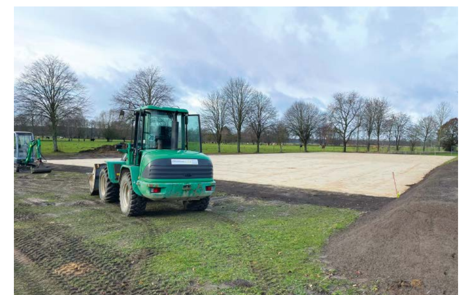
Lasergesteuerte Planierarbeiten der Firma LTB sorgen dafür, dass Sport- und Reitplätze, Gewerbehöfe und Grundplatten perfekt plan sind.
